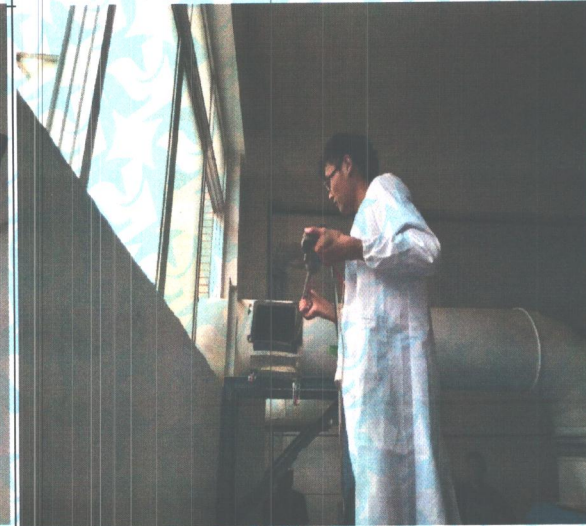
H12 2号楼出粮工序布袋除尘器后端 (1#)
