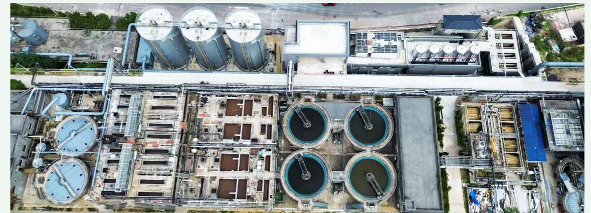
污水处理厂改造升级
