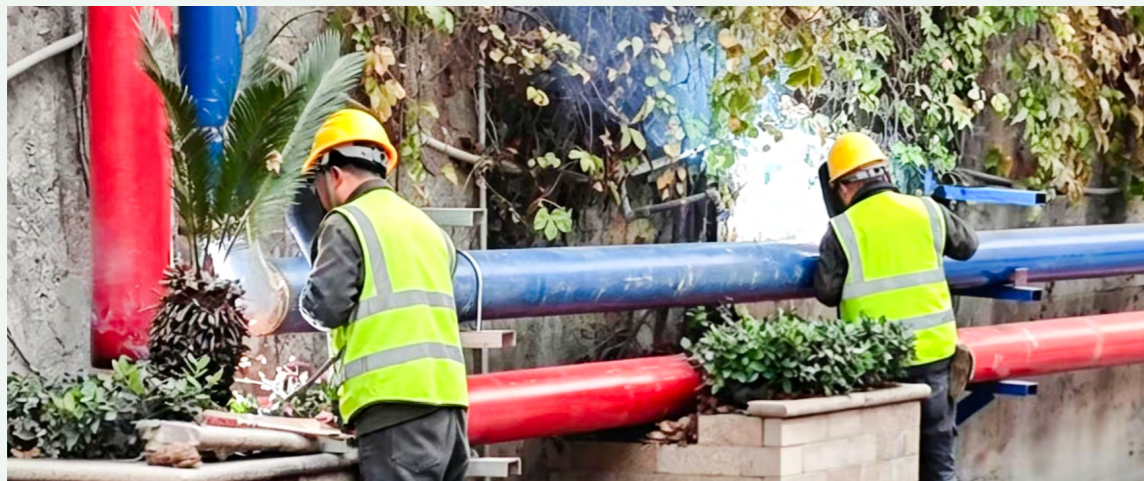
管网节水改造现场
